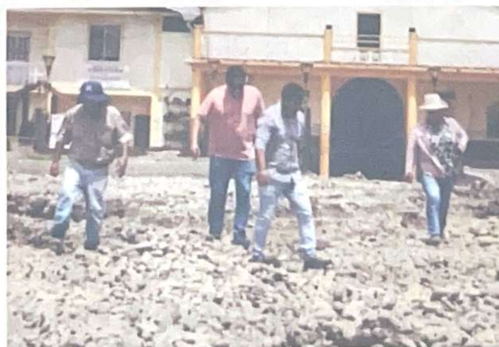
Fotografía 6: Inspección los trabajos de construcción del nuevo Parque Central
