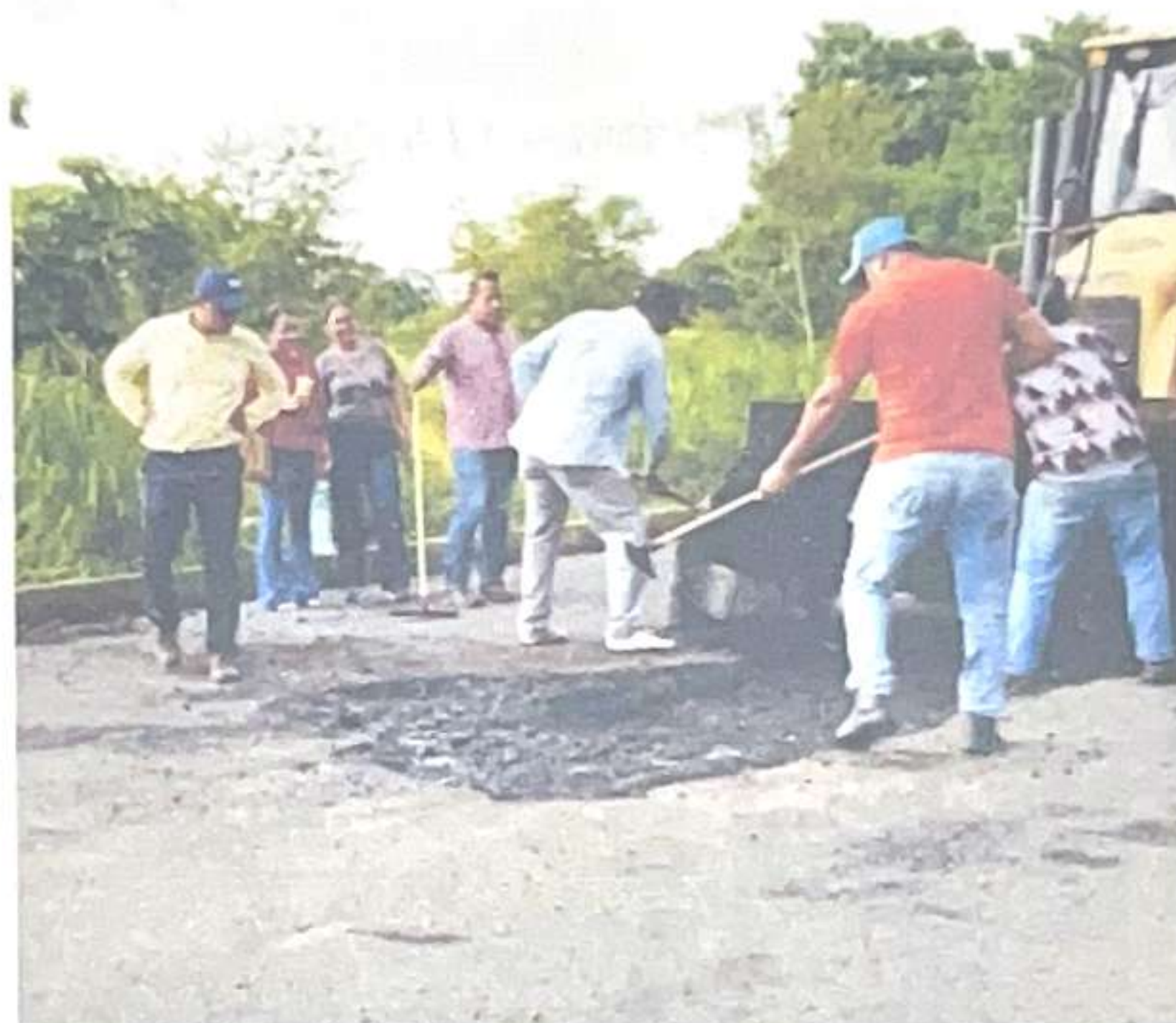
Fotografía 5: Inspección de los trabajos de bacheo que se están realizando en el tramo de ingreso a Palenque
