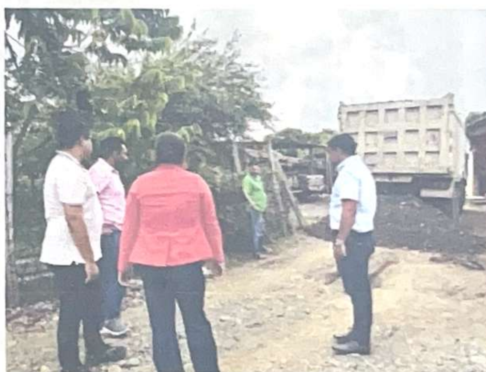
Fotografía 8: Inspección de la reconfiguración del sector las Acacias
