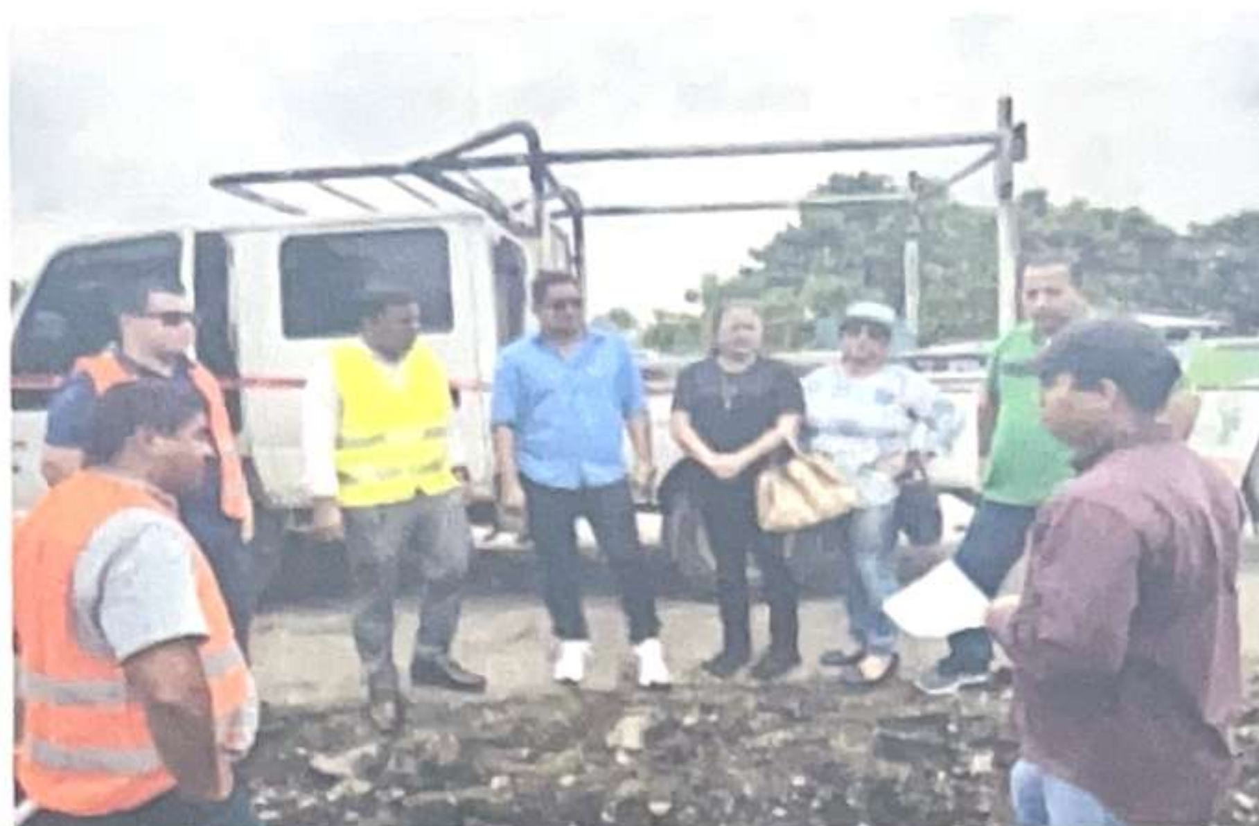
Fotografía 13: Inspección en los trabajos de regeneración en la Av. Juan Carlos
